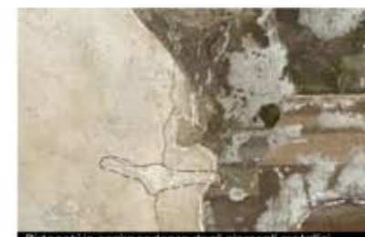
Distacchi in corrispondenza degli elementi metallici
