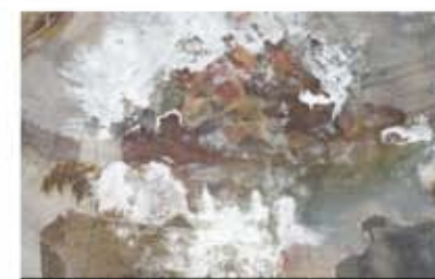
Efflorescenze biancastre con concrezioni saline
