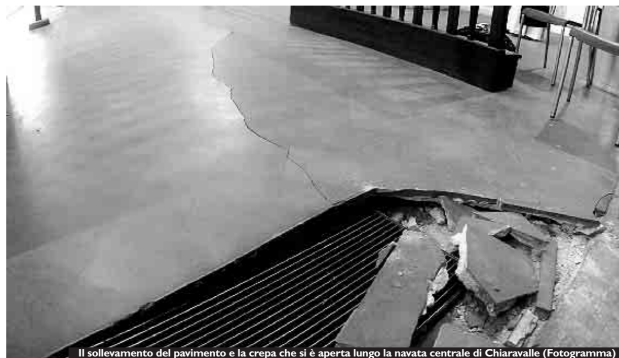
Il sollevamento del pavimento e la crepa che si è aperta lungo la navata centrale di Chiaravalle (Fotogramma)
